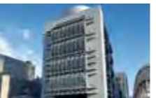
大阪府立国際会議場
